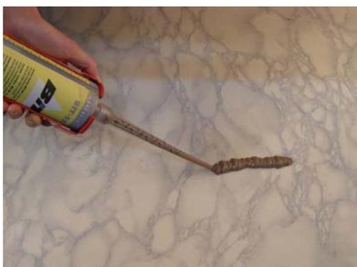
Прокачать химический состав через насадку-смеситель до полного перемешивания компонентов и образования смеси однородного цвета на выходе.
