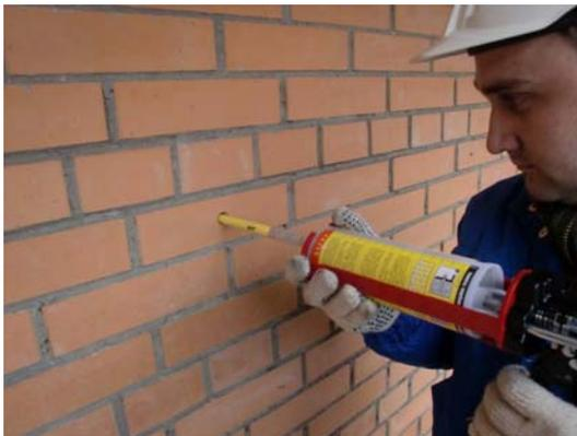
Ввести насадку-смеситель картриджа внутрь сетчатой гильзы до ограничительной полимерной втулки, таким образом, чтобы спиральный анкер располагался внутри насадки-смесителя.
