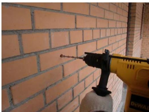
Установить спиральный анкер в проектное положение с помощью перфоратора или ударной дрели с применением специальной насадки BIT-SDS (SDS-Plus).
