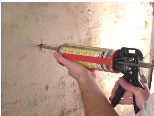
Равномерно заполнить отверстие химическим составом на 2/3 объема начиная со дна и постепенно извлекая насадку-смеситель из отверстия во избежание образования воздушных пузырей.
