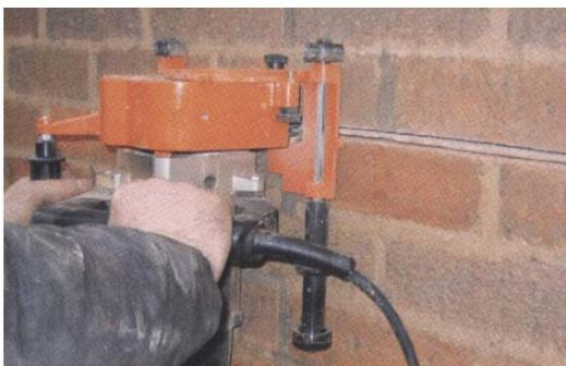
С помощью штрабореза и/или канального долота произвести вычистку раствора из горизонтальных растворных швов с шагом, длиной и на глубину, в соответствии с проектом. Очистить подготовленные швы от строительного мусора и пыли с помощью сжатого воздуха или промыть струей воды.
