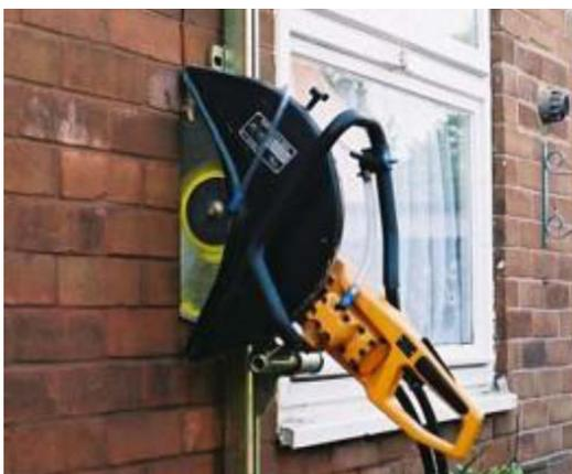
С помощью соответствующего инструмента (штрабореза, отрезной машины, сабельной или цепной пилы) прорезать в облицовочном слое сквозной деформационный шов необходимой ширины (в соответствии с проектом). (Для резания рекомендуются применять сдвоенные или одинарные алмазные диски, соответствующие типу строительного материала).
