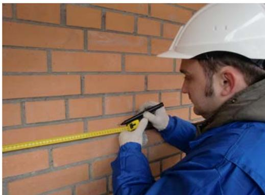
Произвести разметку участка стены для усиления в соответствии с проектной документацией. Обратит внимание на то, чтобы элементы конструкции строительных лесов или подъемника не попадали в зону действия электрического инструмента.
