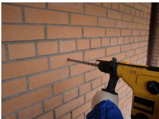
Просверлить отверстие диаметром 13 мм в наружном облицовочном слое. (Внимание! Сверление должно производиться без удара с применением специальных буров для сверления керамического кирпича)
