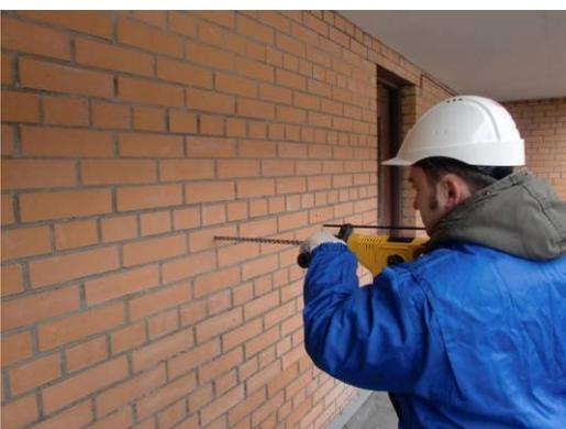
Просверлить направляющее отверстие диаметром 6 мм в наружном облицовочном слое и внутреннем материале конструкции на глубину заделки спирального анкера. (В соответствии с проектом)
