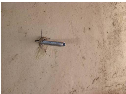
После полного отверждения химического состава возможно приложение нагрузки.
