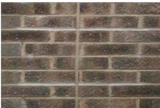
После полного отверждения химического состава заполнить остающееся пространство растворного шва цементным составом и затереть. Затереть трещину по всей длине специальной затирочной смесью для наружных работ соответствующей цветовой гаммы.
