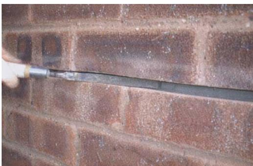
После полного отверждения химического состава заполнить остающееся пространство горизонтального растворного шва цементным составом и затереть.
