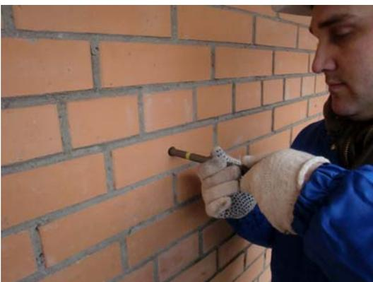
Установить ограничительную полимерную втулку (заглушку) на заданную глубину с помощью металлической или пластиковой оправки.
