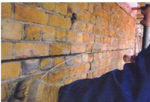
Уложить спиральную арматуру BIT-BAR в подготовленный и заполненный химическим составом паз.
