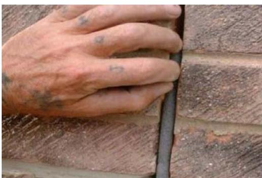
Установить в вертикальный деформационный шов длине упругую уплотнительную прокладку на всю длину соответствующего диаметра и закрыть нетвердеющей мастикой соответствующей цветовой гаммы.
