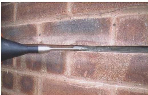
Равномерно нанести химический состав BIT-STICK GROUT на дно горизонтального растворного шва на толщину не более 1 см по всей длине подготовленной штрабы с правой и с левой стороны от вертикального шва.
