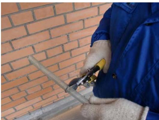
Отрезать металлическую сетчатую гильзу  $\varnothing$  13 мм на требуемую длину (в соответствии с проектом).
