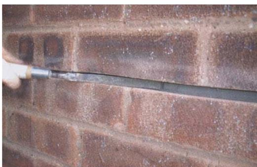
Продолжить заполнение растворного шва химическим составом BIT-STICK GROUT таким образом, чтобы состав полностью покрывал спиральную арматуру с толщиной слоя не более 1 см по всей длине заделываемой части.
