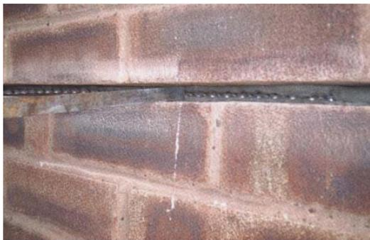
Произвести уплотнение спиральной арматуры в химическом составе с помощью подходящего ручного инструмента.
