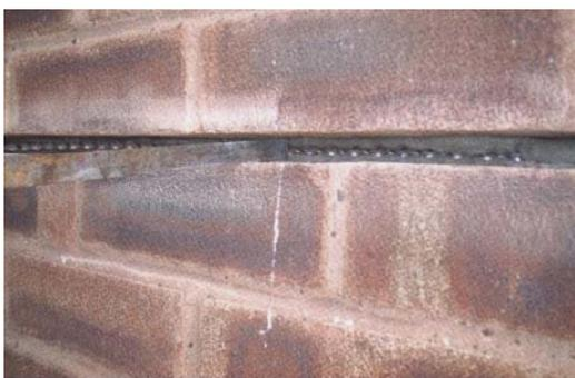
Продолжить заполнение горизонтального растворного шва химическим составом BIT-STICK GROUT таким образом, чтобы состав полностью покрывал армирующий узел и трубку на толщину не более 1 см по всей длине заделываемых частей.
