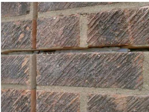
Установить узел BIT-TMJ 6x750 в подготовленный паз горизонтального деформационного шва с помощью подходящего ручного инструмента таким образом, чтобы пластиковая трубка не выступала за край (внутри) вертикального деформационного шва.
