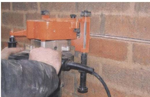
С помощью штрабореза и/или канального долота произвести вычистку раствора из горизонтального растворного шва на глубину и ширину соответствующие проектным. Очистить подготовленный паз от строительного мусора и пыли с помощью сжатого воздуха или промыть струей воды.
