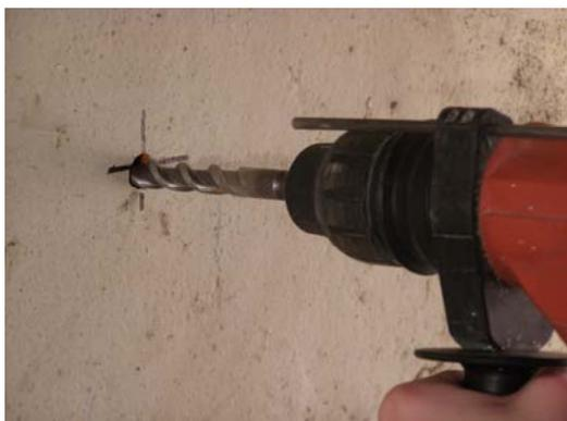
Просверлить отверстие заданного диаметра на требуемую глубину в соответствии с проектом.
