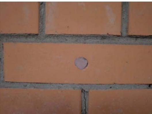
При необходимости удалить излишки химического состава с поверхности облицовочного слоя с помощью шпателя. После полного отверждения затереть поверхность ремонтного отверстия затиркой соответствующего цвета.
