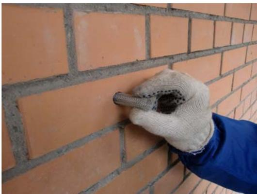
Установить отрезанную сетчатую гильзу в просверленное в наружном облицовочном слое отверстие вровень с поверхностью (заподлицо).
