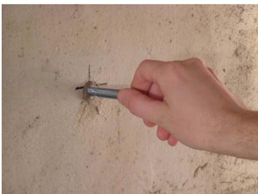
Вращательным движением установить анкерную шпильку или арматурный пруток на требуемую глубину. Корректировку положения анкера возможно производить в период схватывания химического состава.
