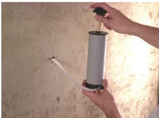
Тщательно продуть насосом или сжатым воздухом (операцию повторить 2 раза)
