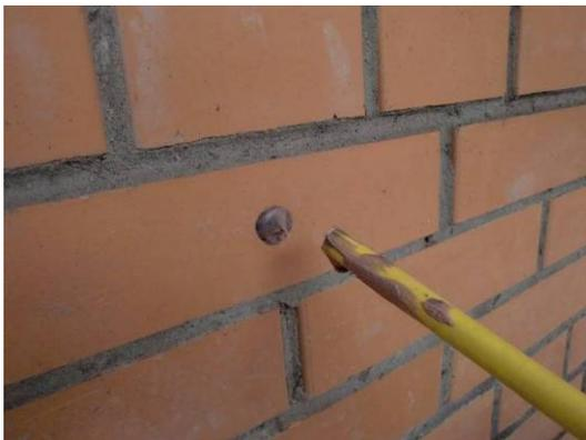
Равномерно заполнить внутренний объем сетчатой гильзы химическим составом постепенно извлекая насадку-смеситель из отверстия.
