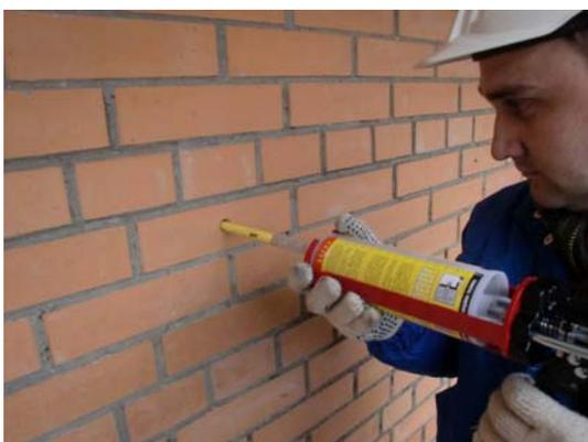
Ввести насадку-смеситель картриджа внутрь сетчатой гильзы до ограничительной полимерной втулки, таким образом, чтобы спиральный анкер располагался внутри насадки-смесителя. Равномерно заполнить внутренний объем сетчатой гильзы химическим составом постепенно извлекая насадку-смеситель из отверстия.
