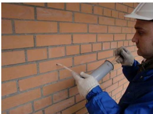
Очистить отверстие от буровой муки и строительного мусора с помощью насоса для продувки отверстий (или компрессора)
