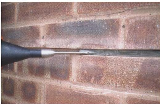
Равномерно нанести химический состав BIT-STICK GROUT на дно растворного шва на толщину не более 1 см по всей длине подготовленной штрабы с правой и левой стороны от ремонтируемой трещины.
