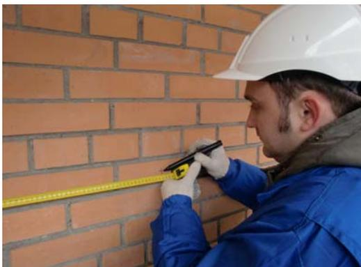
Произвести разметку участка стены для организации вертикального деформационного шва в соответствии с проектной документацией. Обратит внимание на то, чтобы элементы конструкции строительных лесов или подъемника не попадали в зону действия электрического инструмента.
