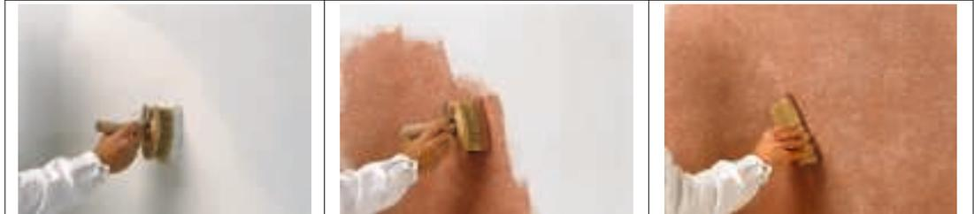
В качестве грунтовочного покрытия нанести щеткой слой Caparol Putzgrund, содержащий кварцевый песок, движениями в "крест на крест" или материалом MultiStrukturStyle валиком с последующим структурированием щеткой движениями в "крест на крест".
