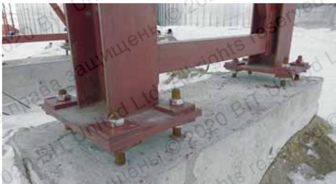
Крепление опорных колонн трубопроводов к монолитным фундаментам (минимальные расстояния от края железобетонного элемента)
